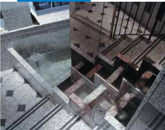
Verlegung eines Granitbelages an Wand und Boden mit Keraquick + Latex Plus - Caesaris Palace in Merseyside - Liverpool (GB)
