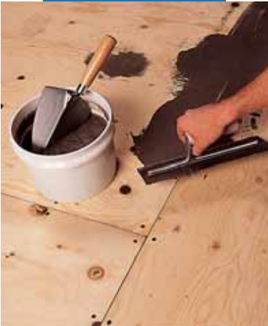
Abspachteln von Fugen bei Holzuntergründen mit Nivorapid + Latex Plus
