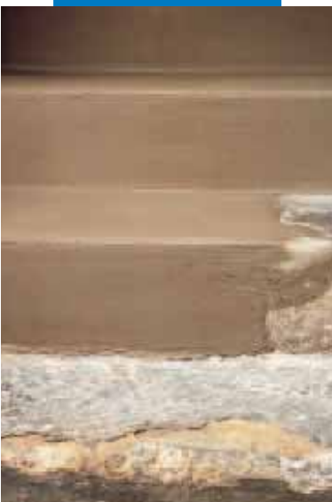
Instandsetzung einer Treppenkonstruktion mit Nivorapid
