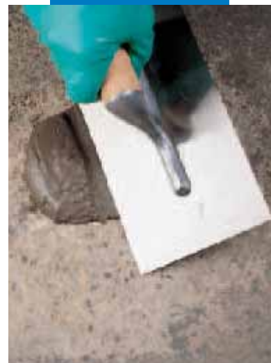
Ausgleich von Ebenheitstoleranzen in einer Betonfläche
