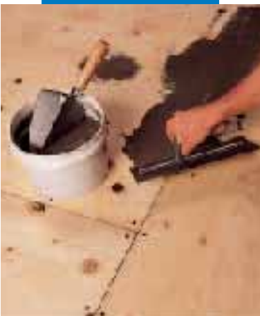
Spachtelung von Sperrholz mit Nivorapid + Latex Plus
