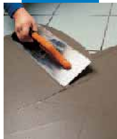
Spachtelung von gereinigten Altbelägen mit Nivorapid
