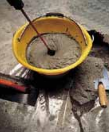
Anmischen von Nivorapid mittels Rührwerk
