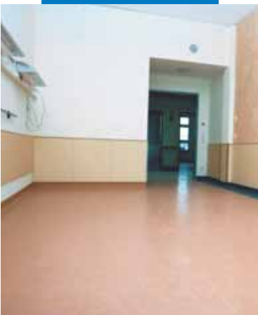
Anwendungsbeispiel für die Verlegung von PVC Platten im St. Josef - Krankenhaus - Deutschland
