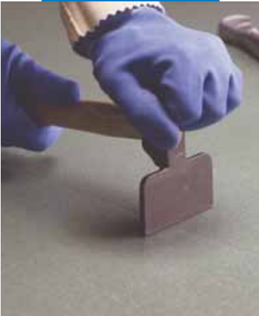
Anreiben des Belages über der Fuge
