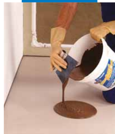
Abstreifen der Tropfkante am Eimer mittels Spachtel
