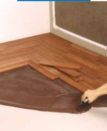
Auftragen des Klebstoffes mit einer Parkettspachtel
