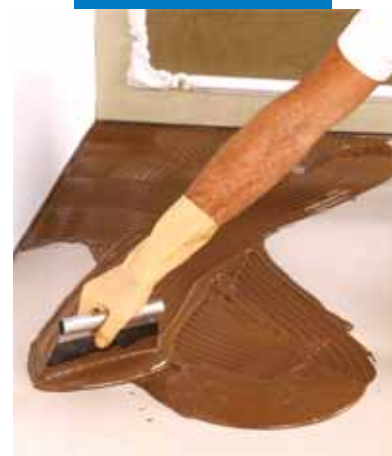
Auftragen des Klebstoffes mit einer Parkettspachtel
